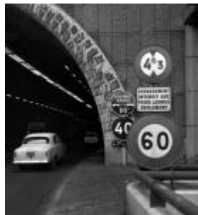
Tunnel de la Croix-Rousse, 1963
