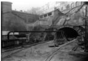
Aménagement lors de la construction du tunnel de la Croix-Rousse, 1952
